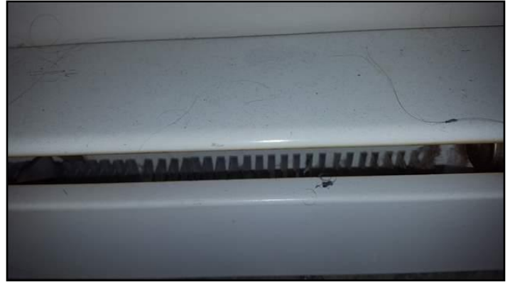
17. Bent fins on heaters
