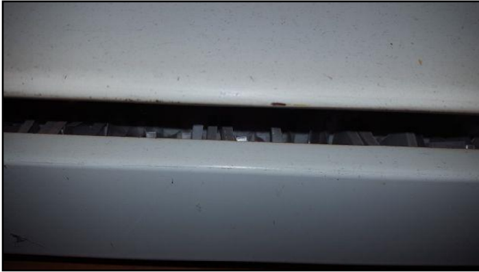
16. Bent fins on heaters
